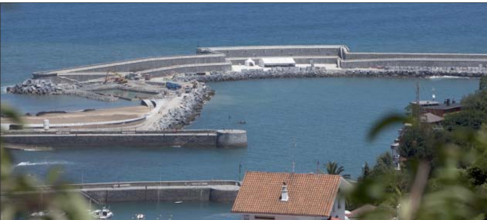
En la imagen, la central undimotriz instalada en el dique de abrigo del puerto de Mutriku
