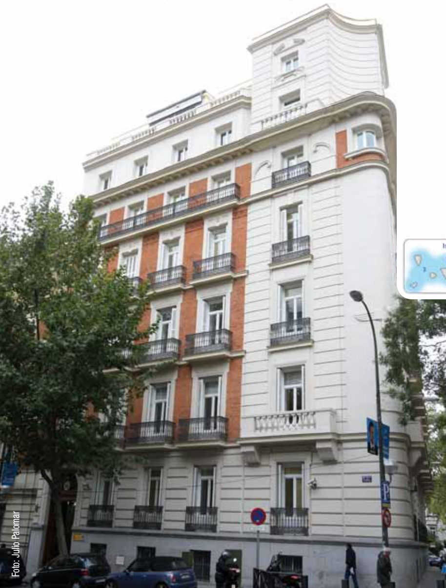
Sede de los Servicios Sociales del ISM en Madrid. Su fachada ha sido rehabilitada recientemente
