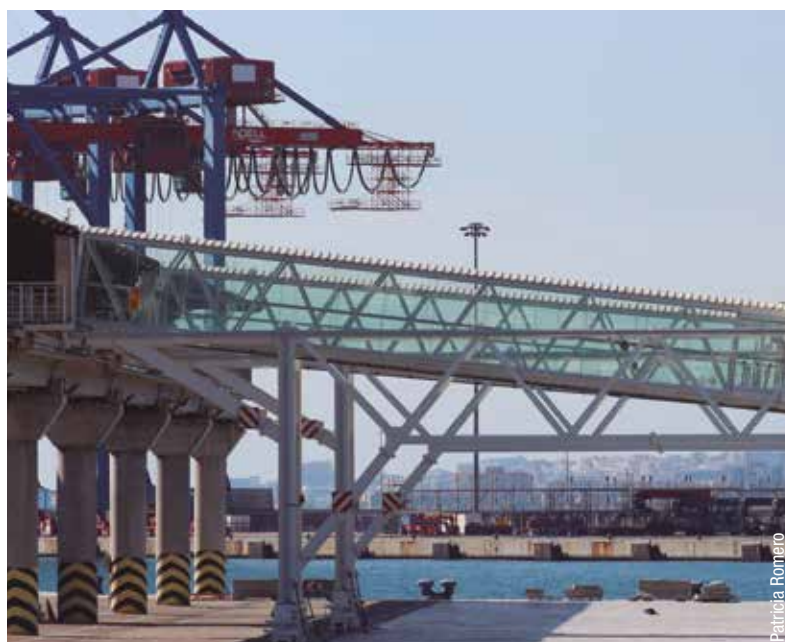
Imagen reciente de la terminal de pasajeros del Puerto de Málaga
