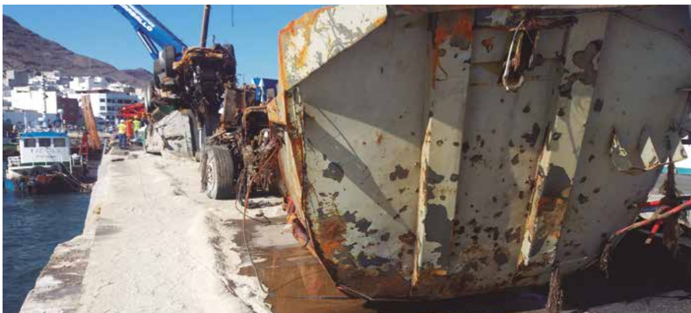
Barrera compuesta por granulados de cantil del muelle que absorbe el hidrocarburo
