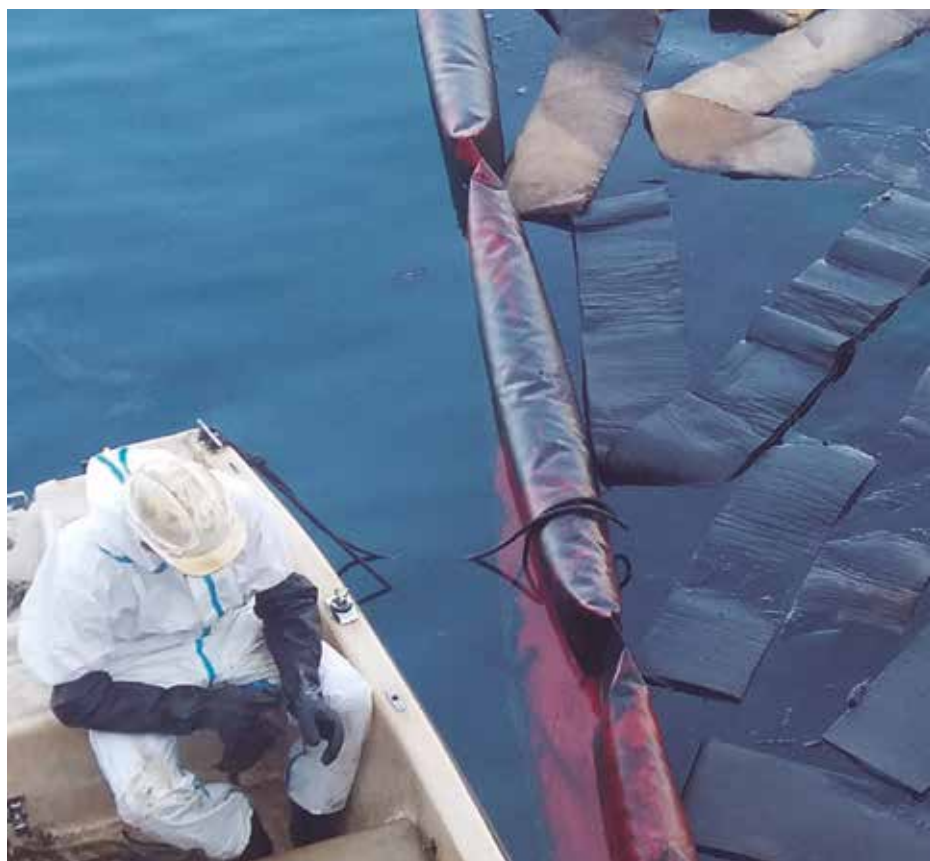
Vista de mantas absorbiendo aceite en la superficie del agua. Una vez exprimidas se vuelven a colocar
