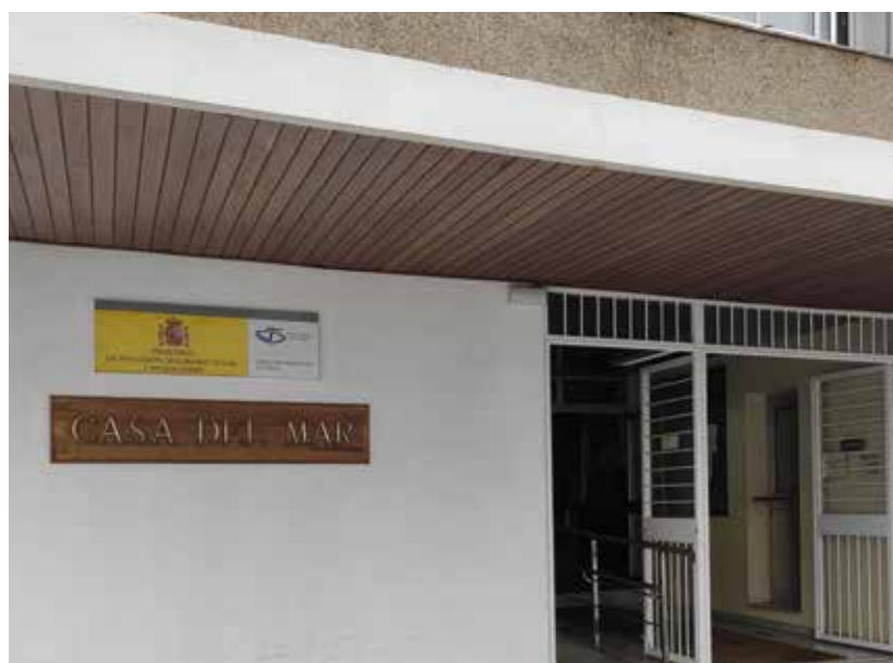
Las placas solares mejoraron la eficiencia energética del edificio
