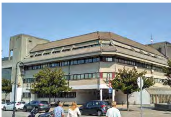
Fachada del antiguo edificio
