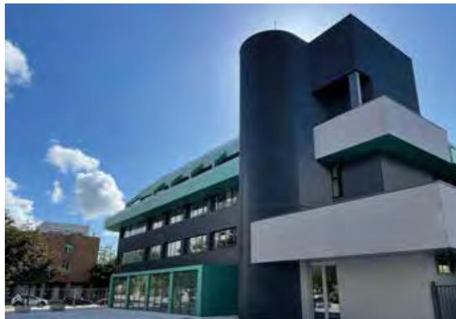
Exterior renovado con materiales de alto aislamiento
