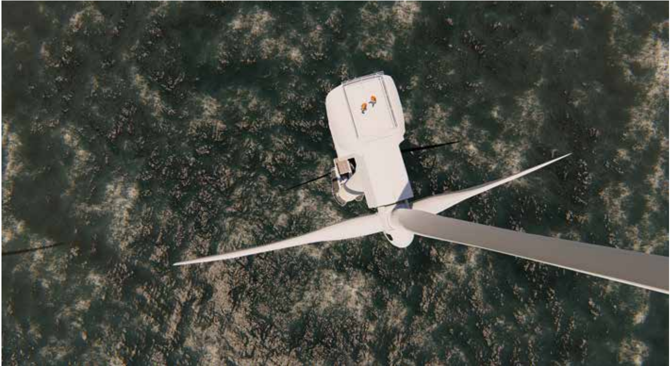
Turbina eólica en el parque eólico de Scroby Sands en el Mar del Norte, Inglaterra
