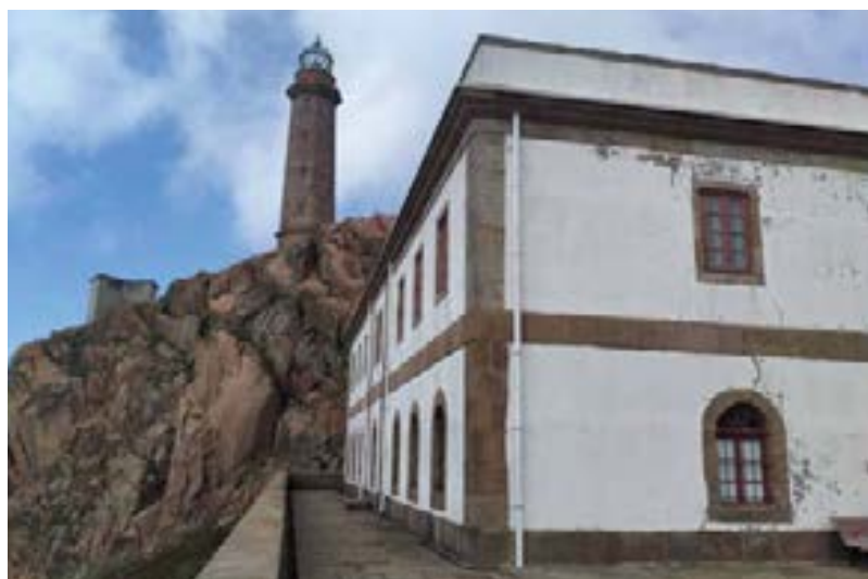
El faro de Cabo Villano se erige a 125 metros de altura
