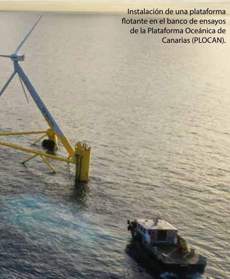
Instalación de una plataforma flotante en el banco de ensayos de la Plataforma Oceánica de Canarias (PLOCAN).
