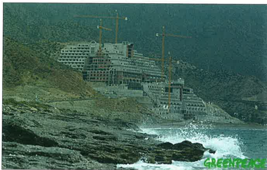
Ningún lugar, aunque sea protegido, está a salvo del cemento. Hotel en construcción dentro del parque cabo de Gata-Níjar. Playa el Algarrobico (Almería). Greenpeace.
