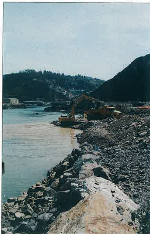
Obras de ampliación del aparcamiento en el puerto de Cudillero, Asturias. Greenpeace.
