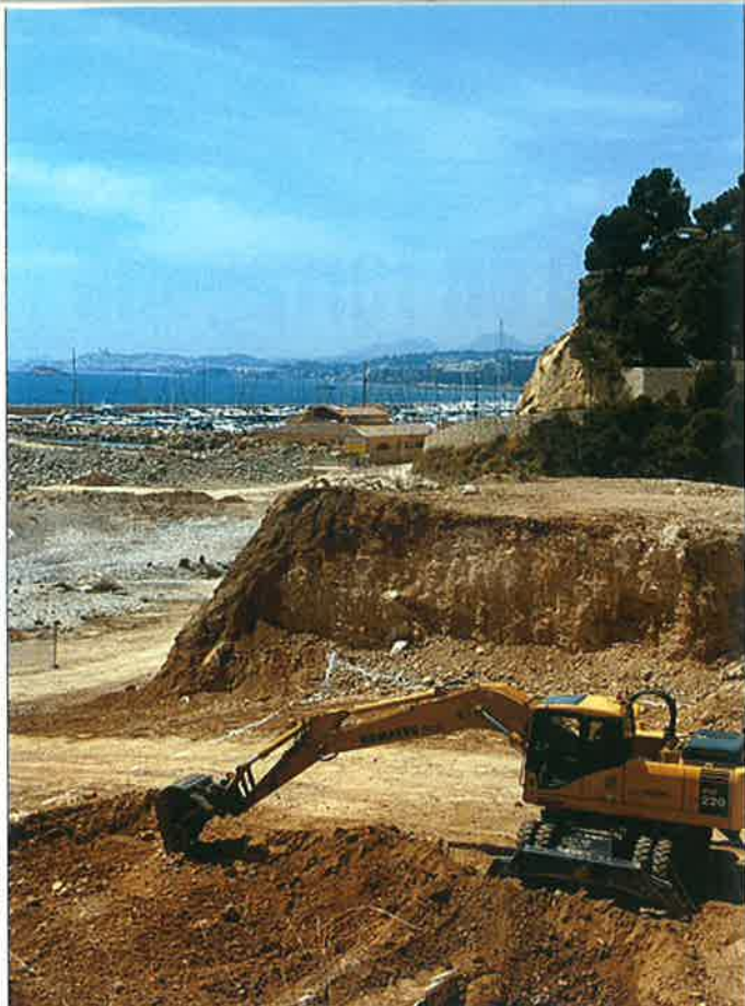
Trabajos para la ampliación del puerto deportivo Luis Campomanes, en Altea (Alicante). Greenpeace.
