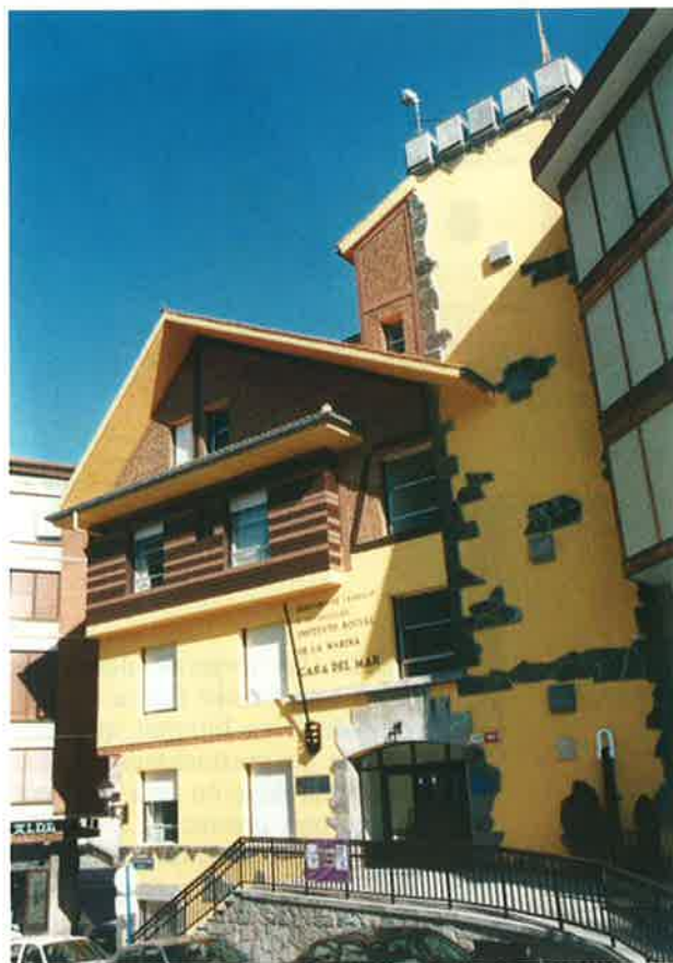
Casa del Mar de Bermeo (Vizcaya).
