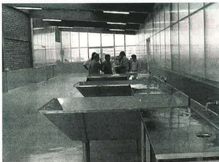
Las nuevas instalaciones del puerto artesanal pesquero de Ilo.
