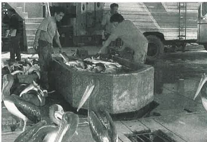
Antiguas instalaciones del puerto de Ilo.
