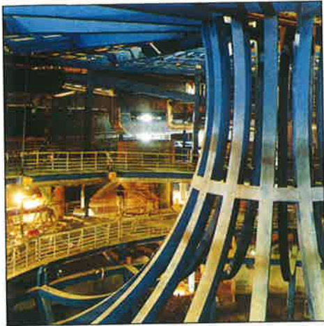
Interior del Pabellón del Futuro
