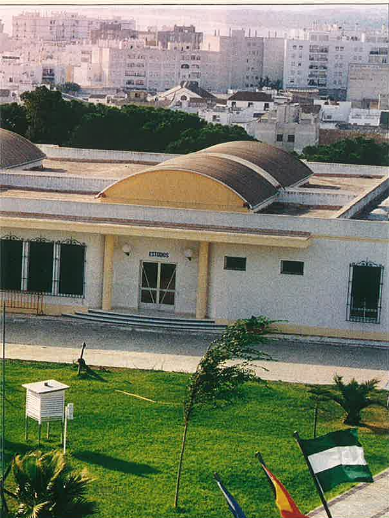
Principal del colegio, con la ciudad de Sanlúcar de Barrameda al fondo.
