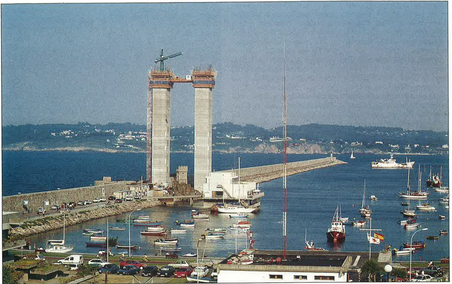
En la construcción de la torre se han empleado 6,000 metros cúbicos de hormigón y unos 400,000 kilos de acero.
