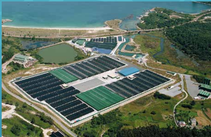
Vista aérea de tanques de engorde, tuberías perimetrales y balsa decantadora.
