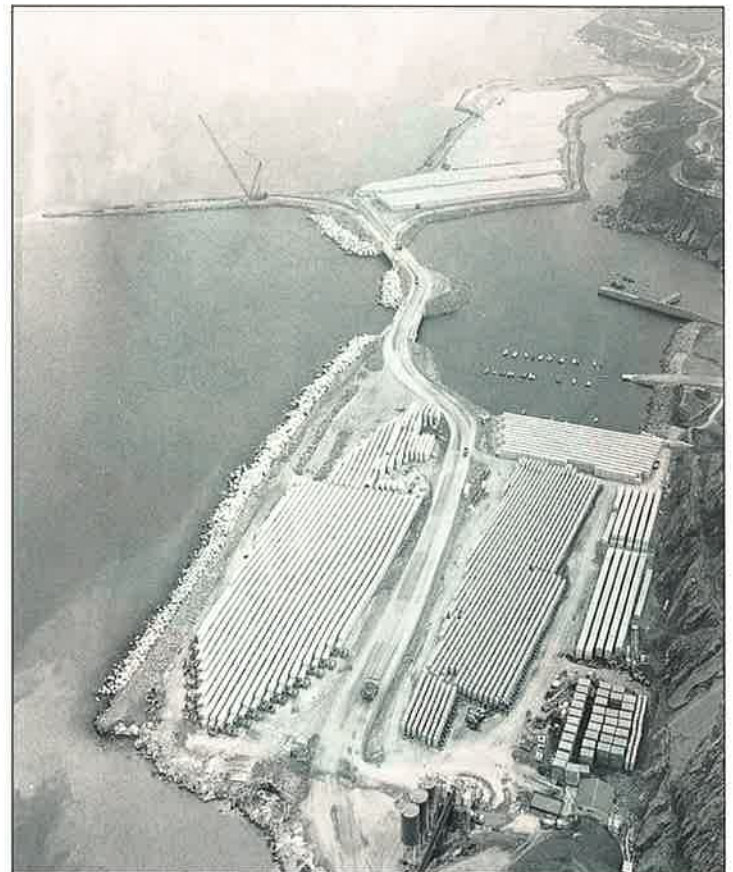
Vista de las obras de ampliación del puerto de Bilbao a julio de 1994.
