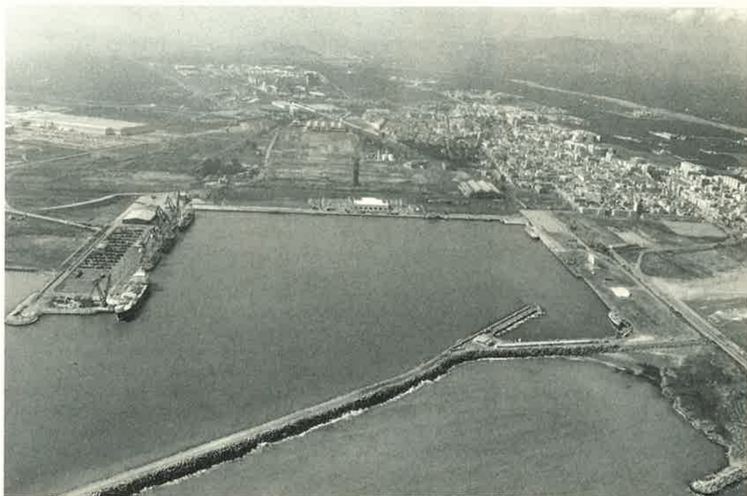
Vista aérea del Puerto de Sagunto.
