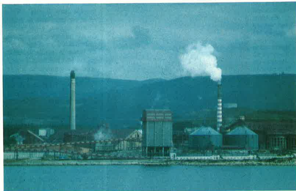
Enclave industrial de Alúmina-Aluminio, entre Cillero y Burela.
