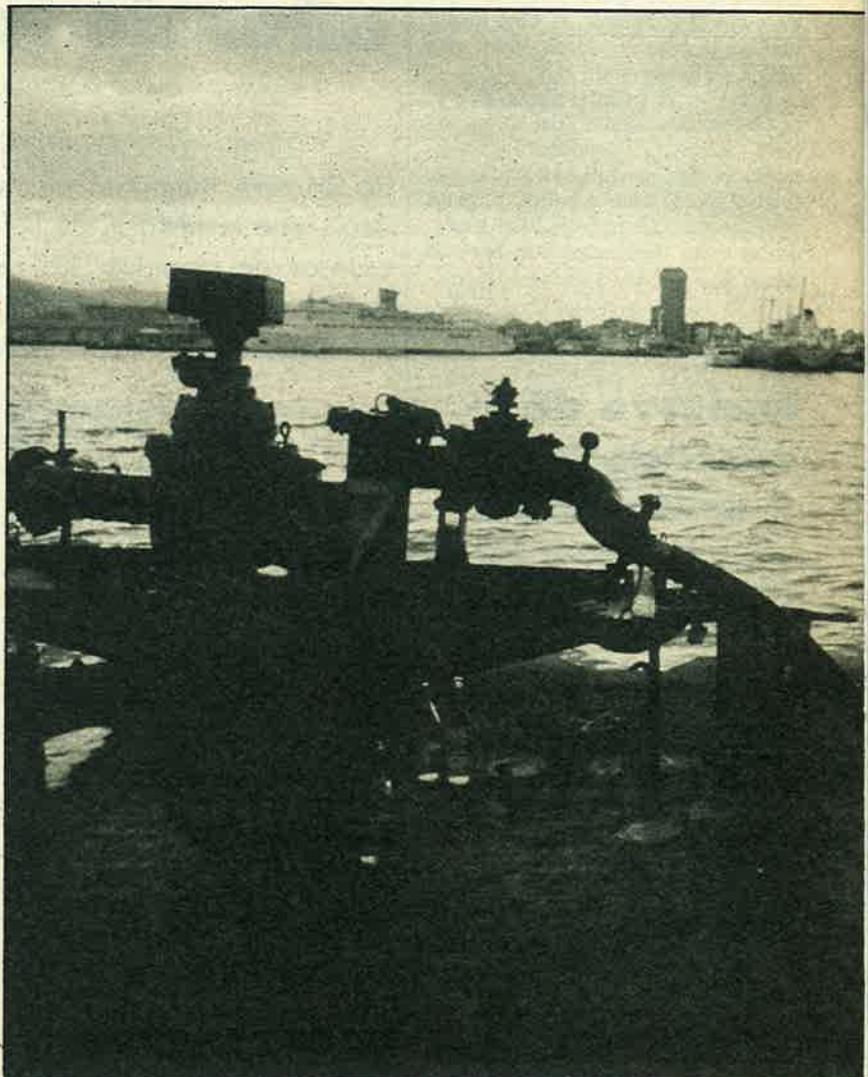
Motor para bombeo del combustible de la red general del puerto de La Luz, a los barcos
