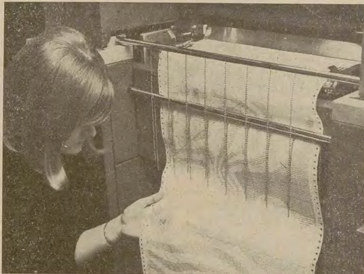
MAPAS POR COMPUTADORES. —Arriba: Los computadores hacen ahora los mapas del tiempo en Inglaterra. La máquina recibe informaciones de 1.200 estaciones meteorológicas, 300 barcos y 600 globos sonda, y en 25 minutos produce mapas numéricos, cuyos facsímiles son remitidos a todos los países asociados.
