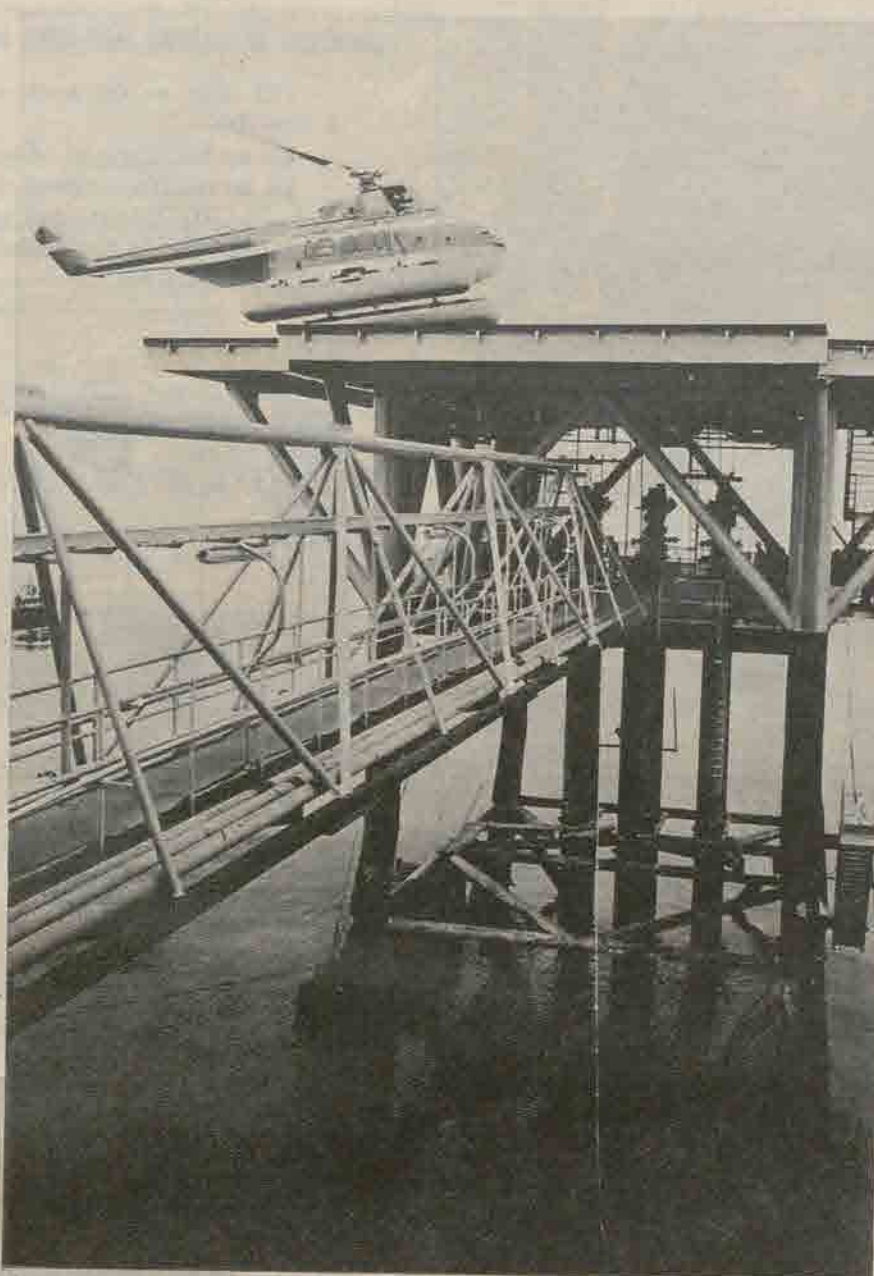
Uno de los dos helicópteros actualmente en servicio se posa sobre la torre menor. En el centro, entre los soportes que se clavan en el fondo, se distinguen las tuberías para el petróleo a extraer. (Fotos: DASOY.)
