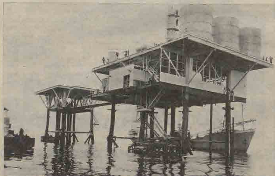
El complejo de producción San Carlos I y II, instalado frente a las costas mediterráneas, con base en el puerto de San Carlos de la Rápita, sobre fondo marino, a 60 metros de profundidad y a 20 sobre el nivel del mar.
