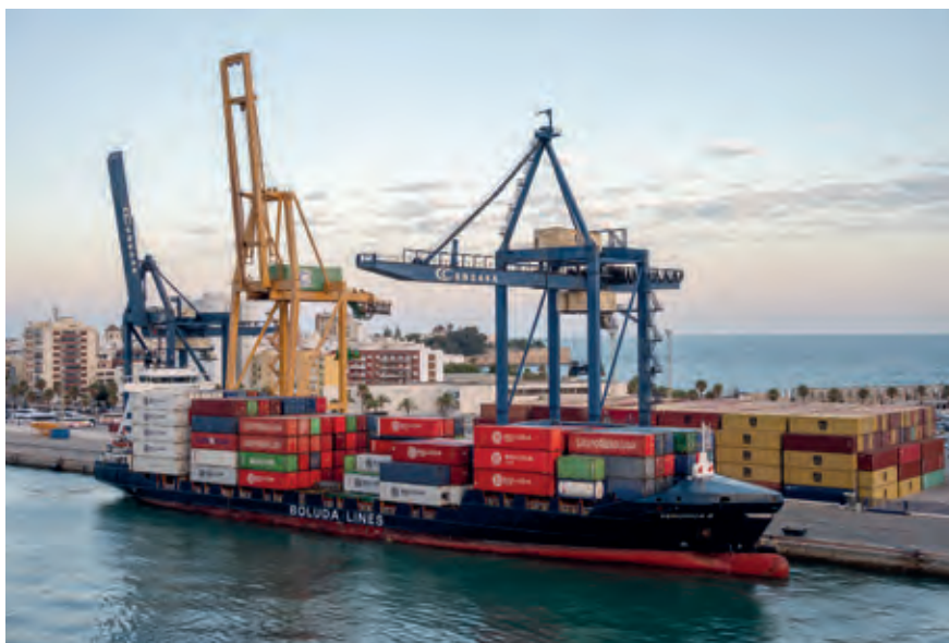
Buque portacontenedores en el puerto de Cádiz.
